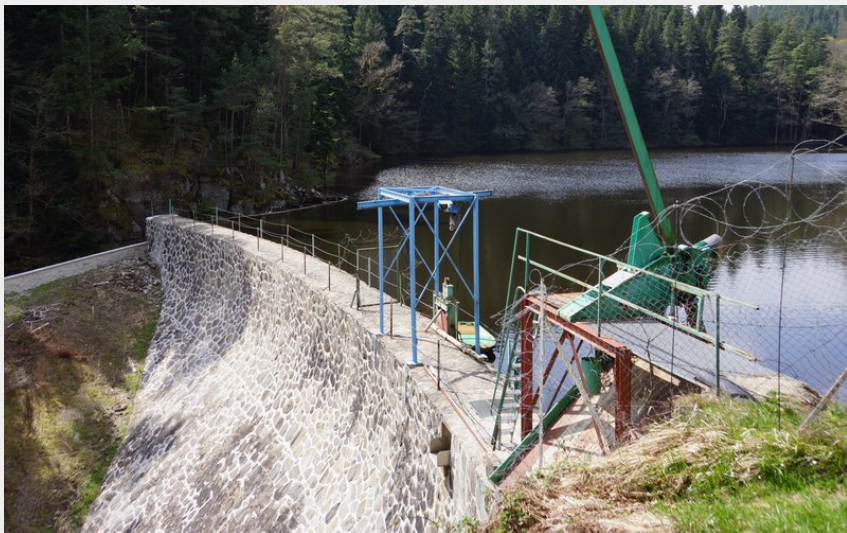
Barrage de Chalas (MDT)
