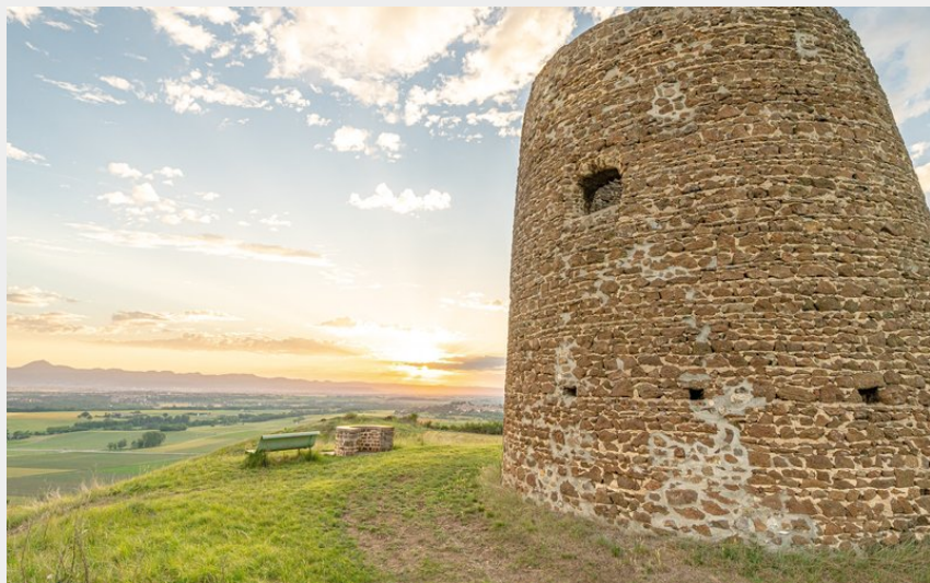
La tour de Courcourt (© Denis Grudet/CC Entre Dore et Allier)
