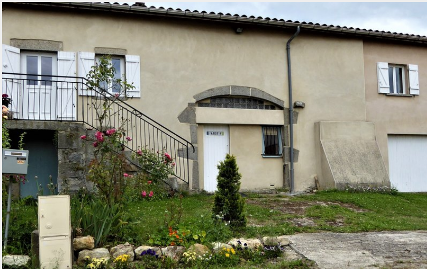
Crédit photo : Vue extérieure (Marie Calderon)
