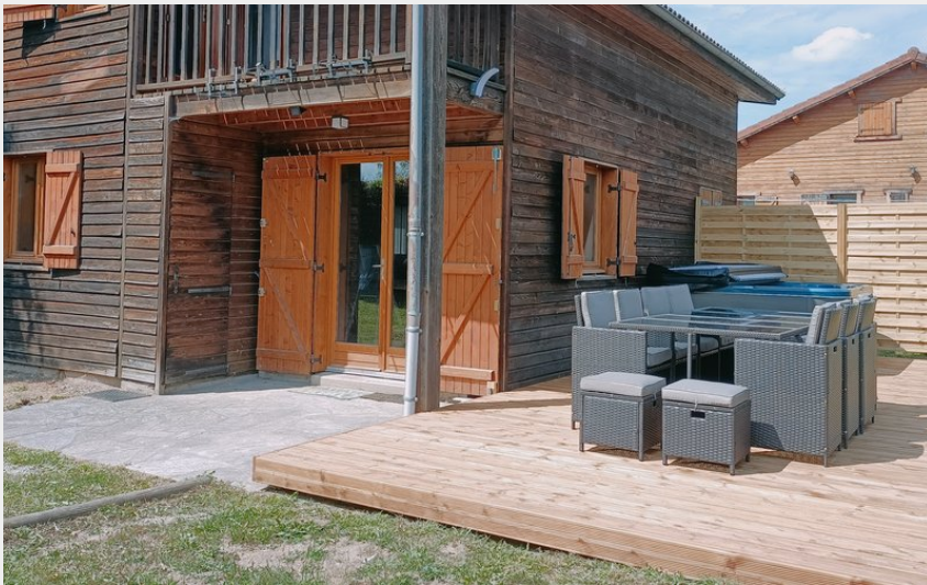
Crédit photo : Façade (SCI BEMISA)
