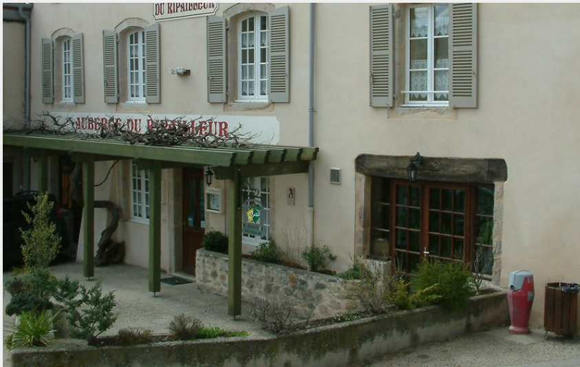
Crédit photo : Auberge du Ripailleur (Boyer)
