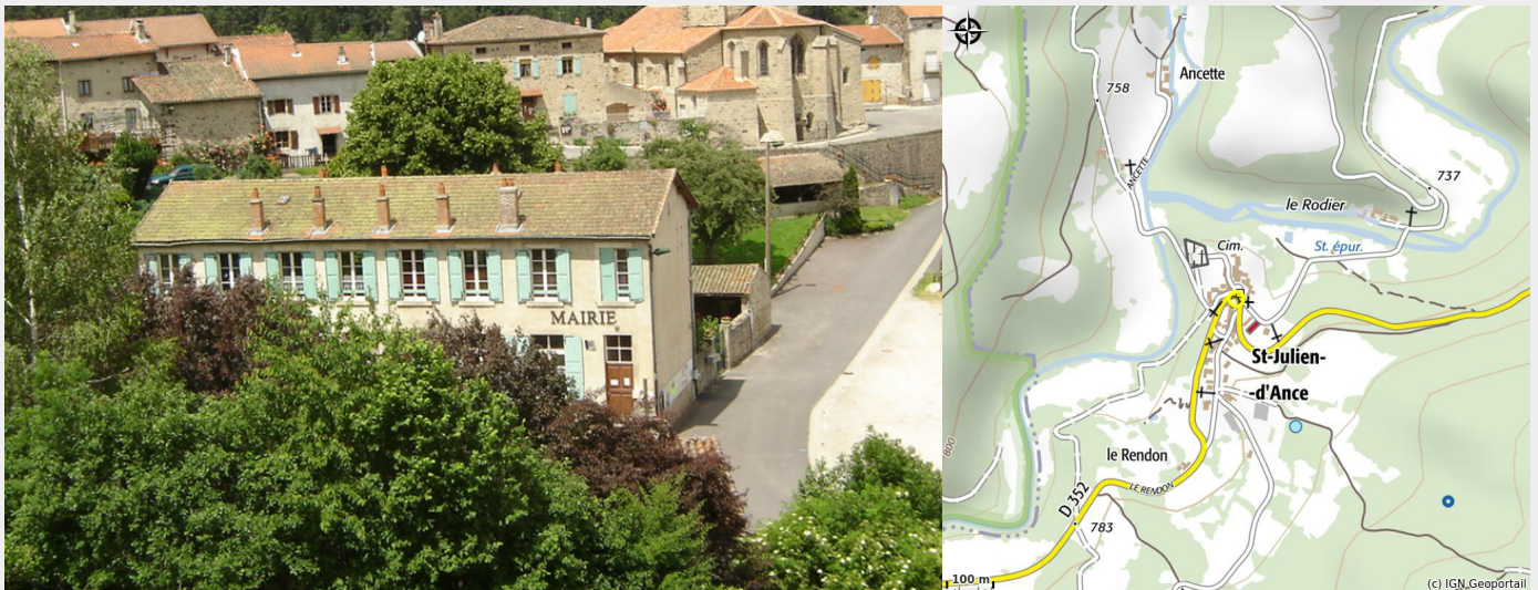
Crédit photo : PCU_EgliseStJulien2 (Office de Tourisme)
